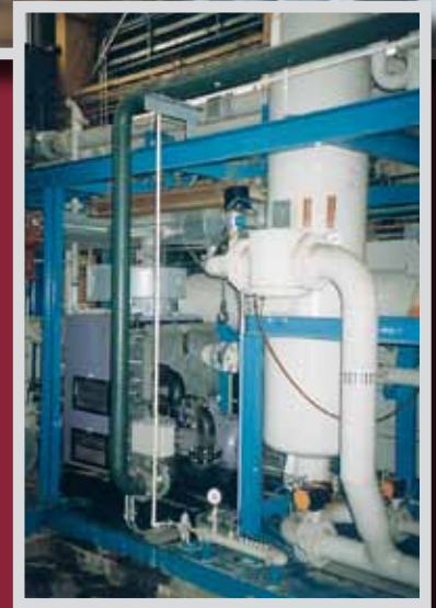
Regeneration von Adsorptions- kolonnen für Stahlherstellung / regeneration of adsorber columns at steel production
